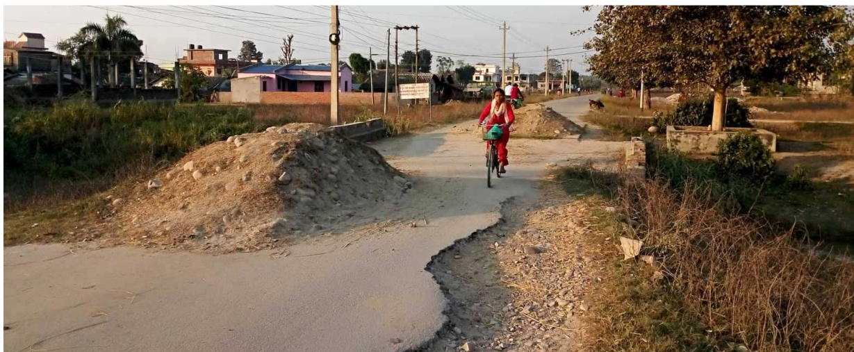
टीकापुर नगरपालिका ब्लक नं ११ मा वर्षौदेखि ठूला सवारी साधन नचल्ने गरी बन्द बाटो भत्केको कल्भर्ट
